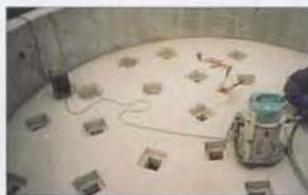
FIGURE 9 - GLASS BLOCKS TO BE USED FOR LIGHTING
